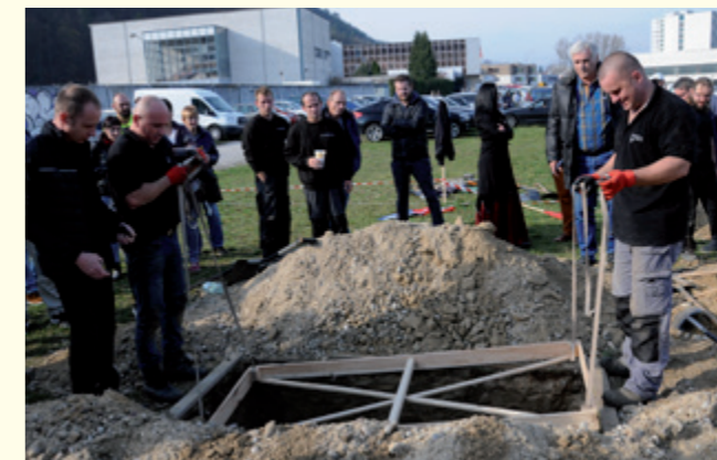
Pomiar prawidłowości i dokładności wykonanej pracy
